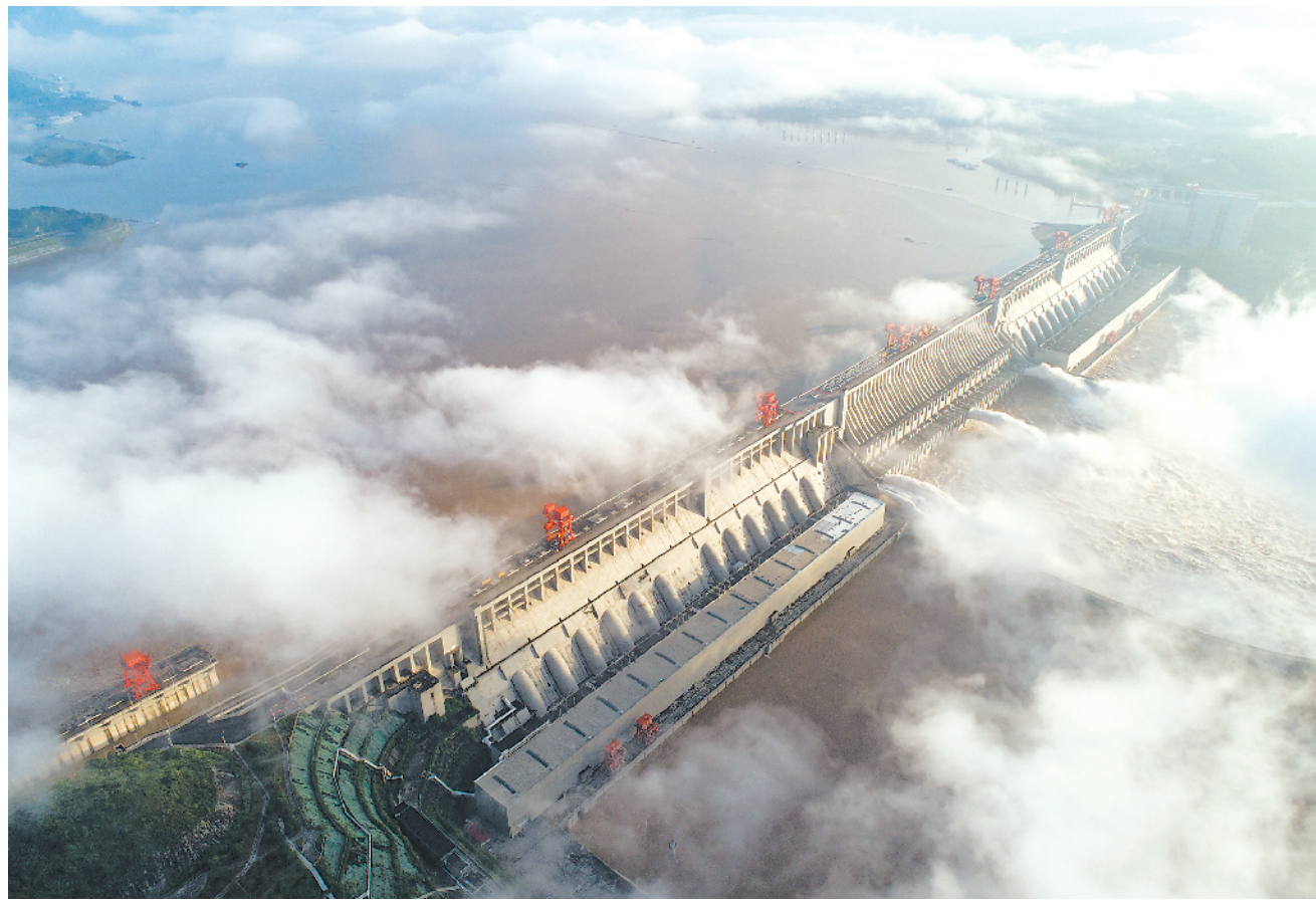
7月27日,长江三峡枢纽工程开启泄洪深孔泄洪(无人机照片)。7月26日14时,受长江上游强降雨影响,三峡水库入库流量达50000立方米每秒,迎来长江2020年第3号洪水,27日14时洪峰流量达到60000立方米每秒,拦洪削峰达36.7%。 新华社发
